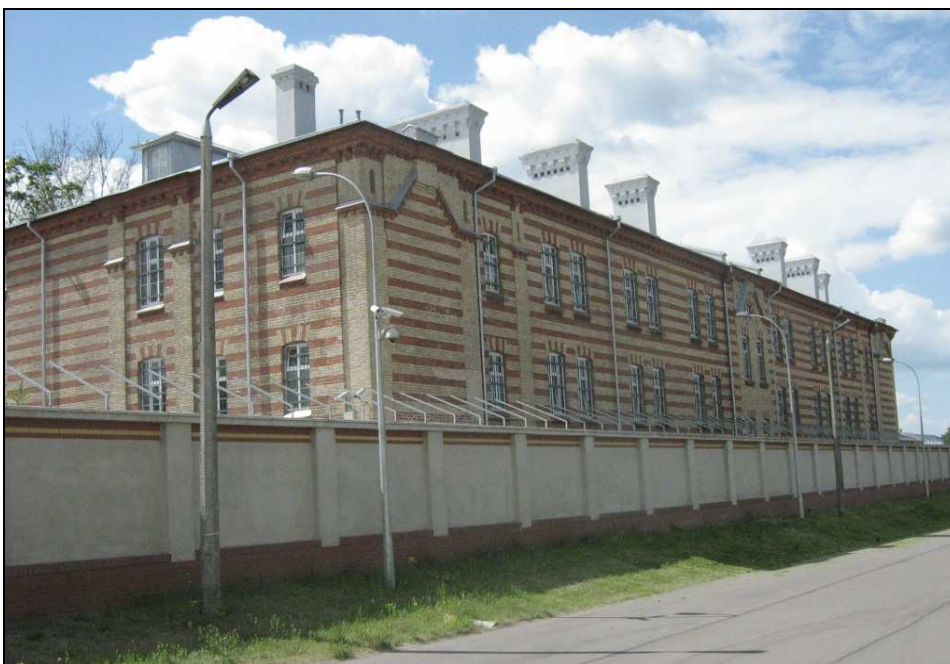
Jedyny koszarowiec na terenie Podlaskiego Oddziału Straży Granicznej o niezmienionej elewacji pamiętającej czasy 14 dak-u mieści dziś Ośrodek Strzeżony dla Cudzoziemców (zdjęcie ze zbiorów Autora).
